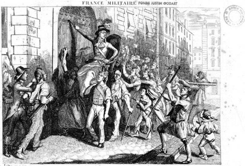
Destruction des Édifices de Lyon
